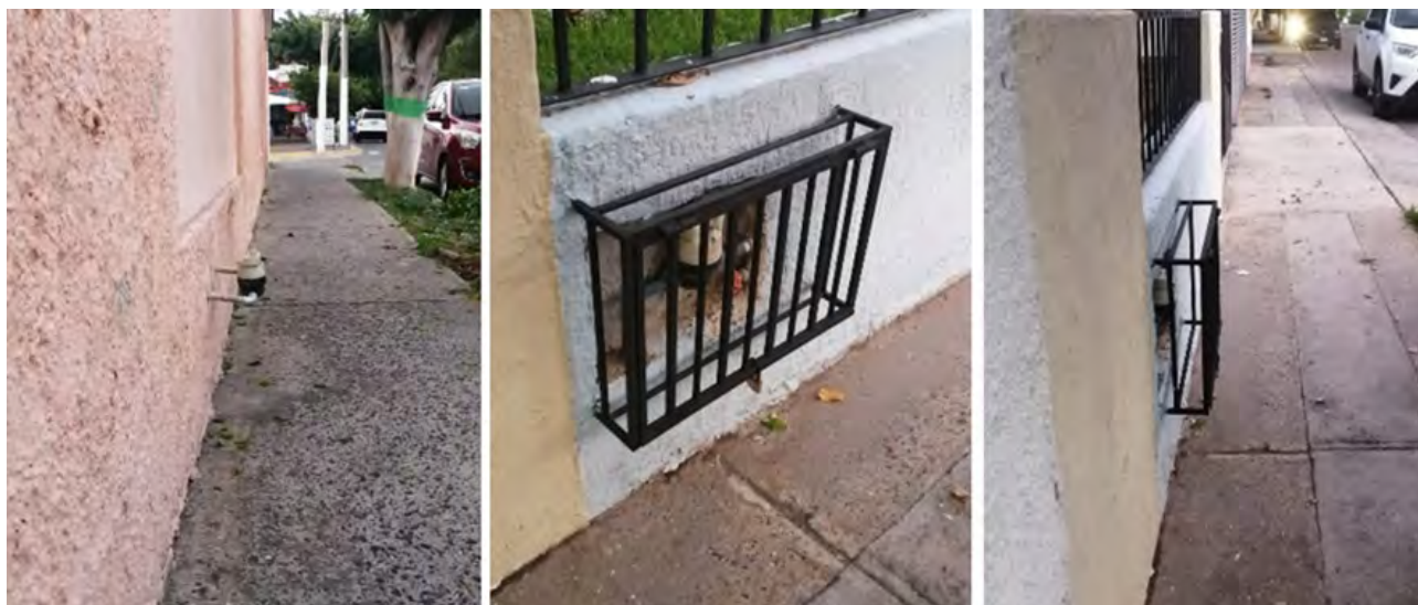
Figura 2. Medidores de agua salientes de construcciones en las banquetas
